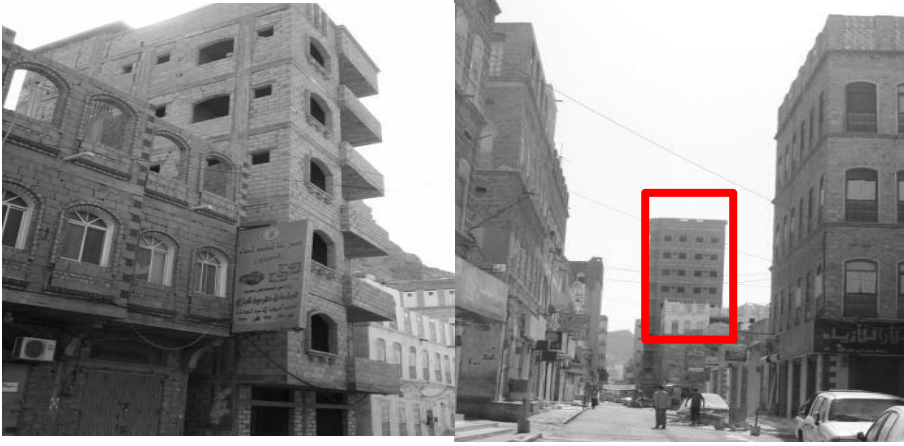
شكل رقم (18) واجهات المباني الجديدة بدون تشطيب.
