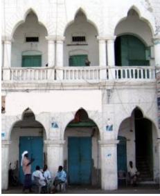
مبنى سكة يعقوب وبه عقد نفل بثلاث حليات.
