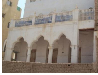
مبنى سكني وبه عقد نفل بثلاث حليات.
