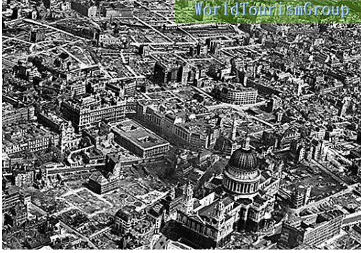
صورة بعد إعادة البناء والترميم في عام 1966
