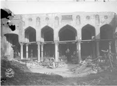
صور للمسجد أثناء الترميم
